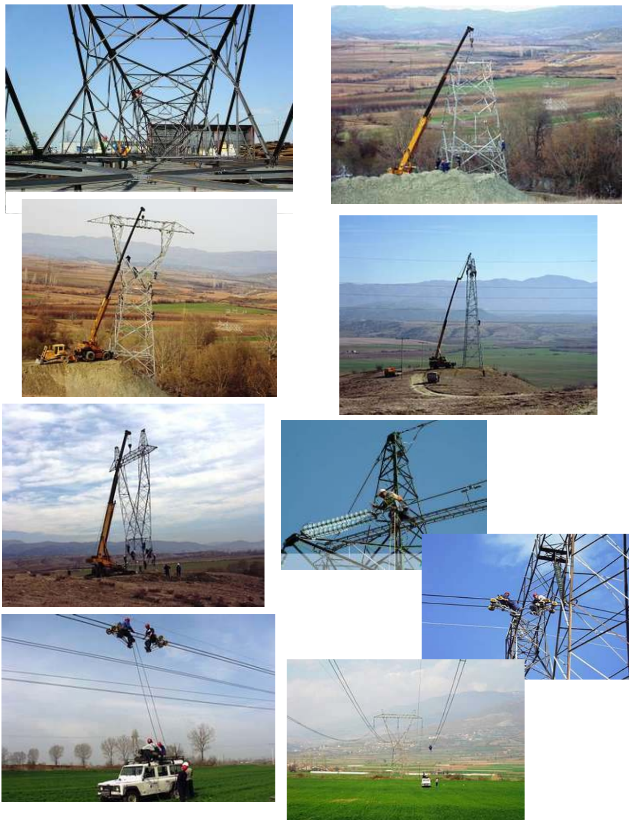
Слика 2-3 -- Изградба и инсталација на 400 kV далекувод
