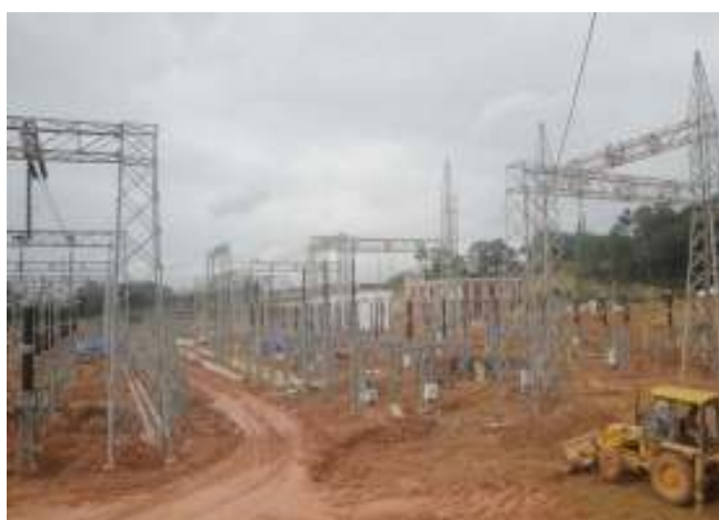
Слика 2-6 — Изградба и инсталација на инфраструктурата на трафостаницата
